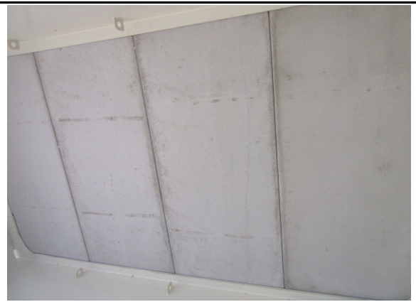
바닥판 하면(LB-DECK) 시공 상태 점검
