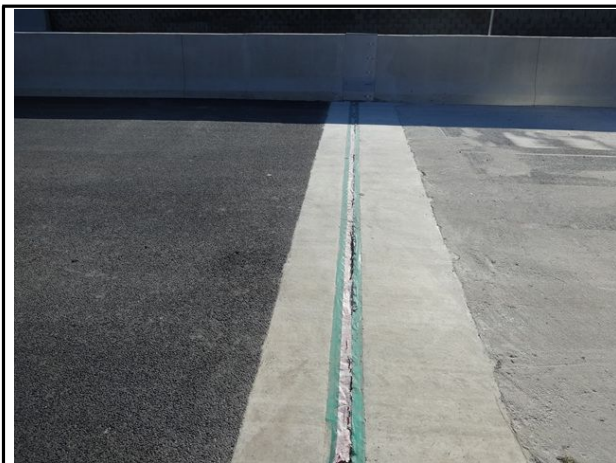
신축이음 A2 전경
