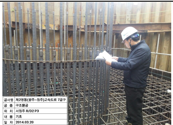
P3 기초 시공 상태 검측
