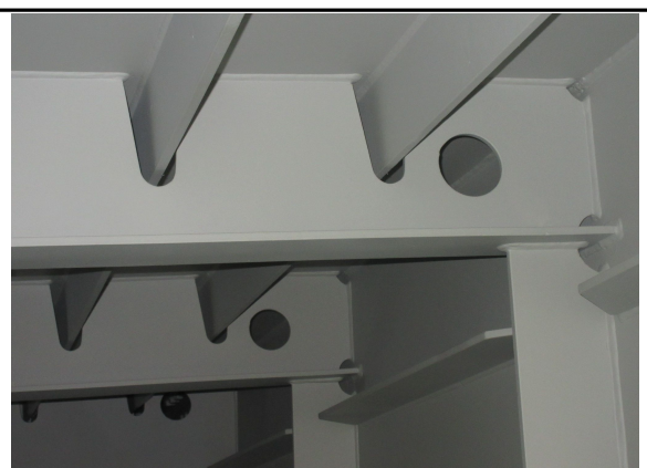
BOX 내부 시공 상태 점검
