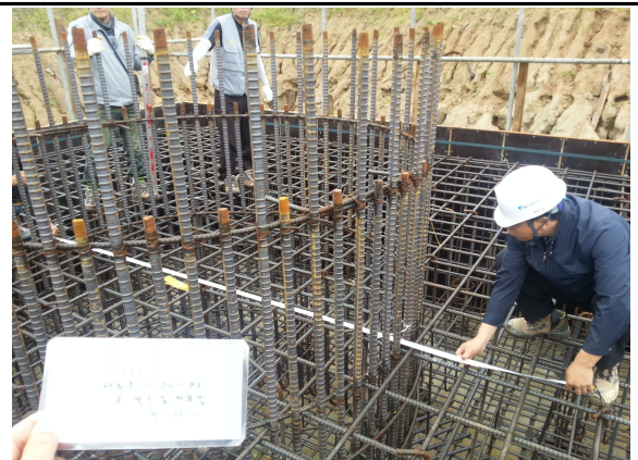
P1 기초 시공 상태 검측
