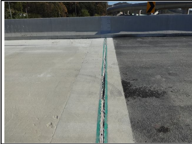
신축이음 A1 전경
