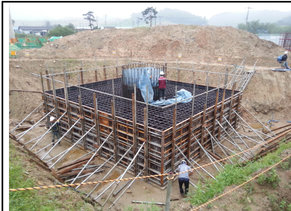
P1 기초 시공 현황
