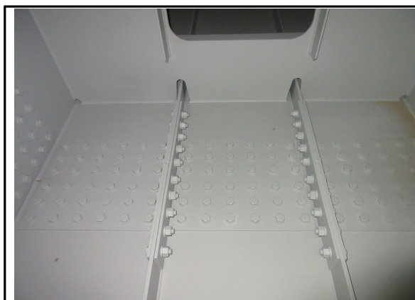
BOX 내부 시공 상태 점검
