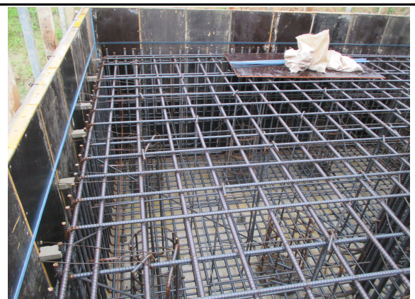
P1 기초 시공 현황
