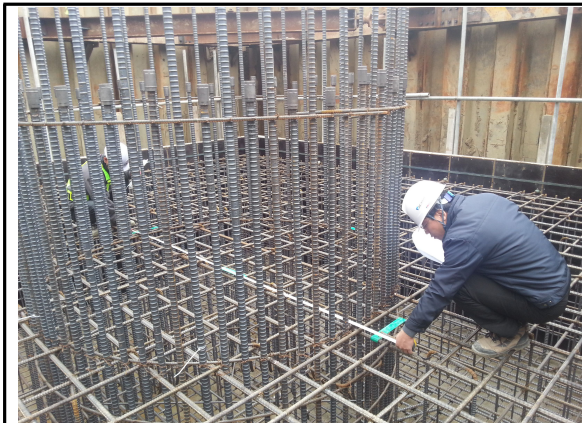
P3 기초 철근배근간격 측정
