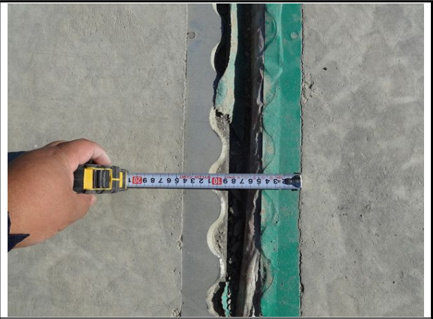
신축이음 A1 유간 측정
