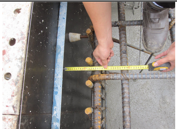
P2 기초 시공 상태
