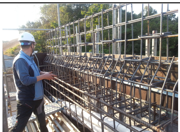
A2 기초 철근조립 상태
