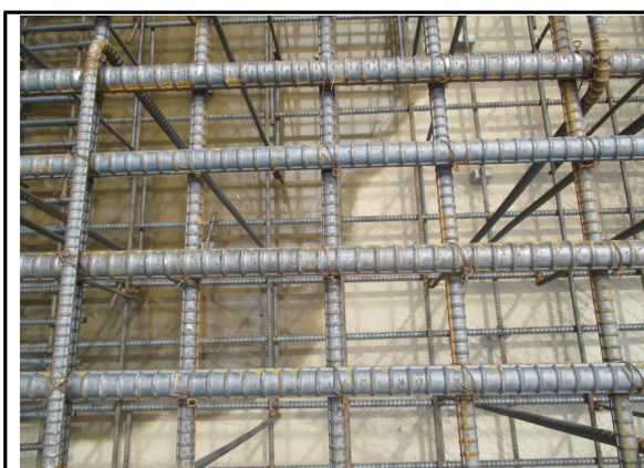
P2 기초 시공 상태
