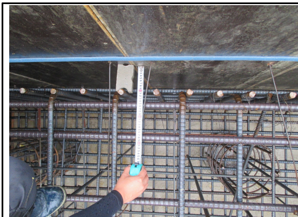
P1 기초 시공 현황
