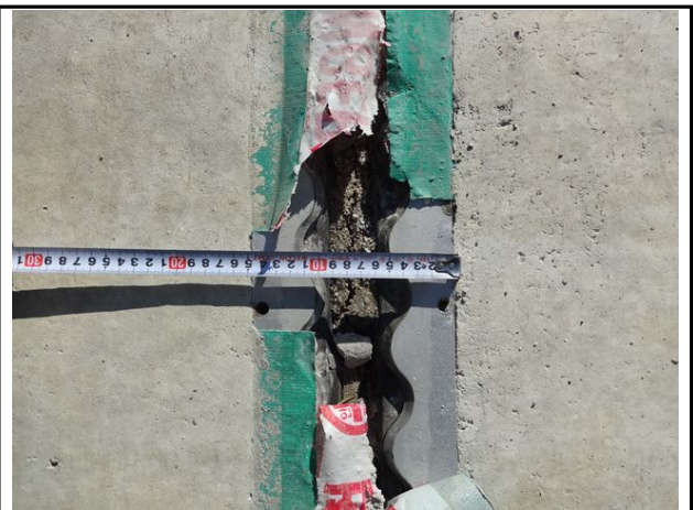
신축이음 A2 유간 측정
