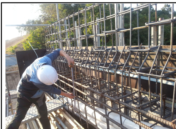
A2 기초 철근조립 상태 점검
